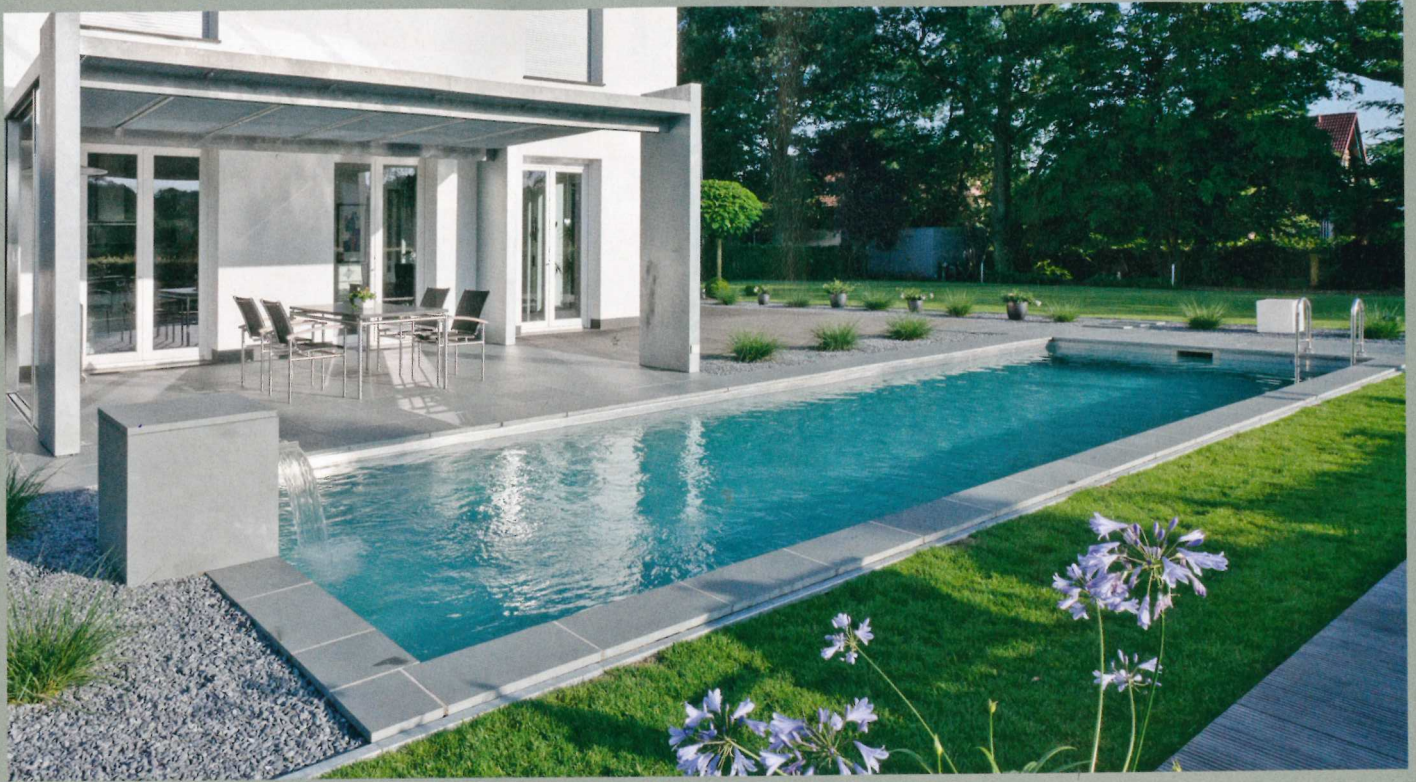
Der „Living-Pool“ vermittelt eher den Charakter eines herkömmlichen Swimmingpools. Dennoch funktioniert auch seine Wasseraufbereitung auf biologischer Basis, wenngleich stark technisiert.
